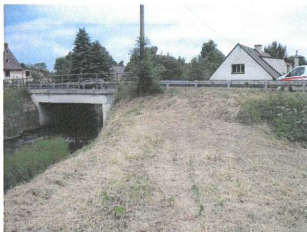
Foto 2 Konec LB hráze se zavazuje do silničního tělesa.
